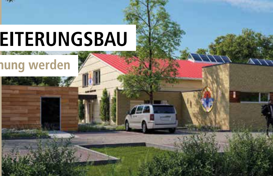
Vorderansicht des Erweiterungsbaues Foto: BTP Architektur- und Ingenieurbüro Brockmann & Tolan
